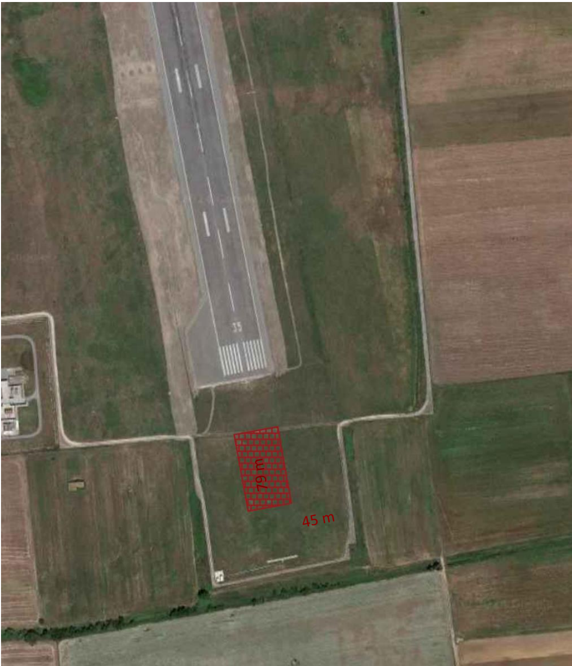
Figura 18 – Realizzazione EMAS (45 X 79 metri) a fine pista 17
