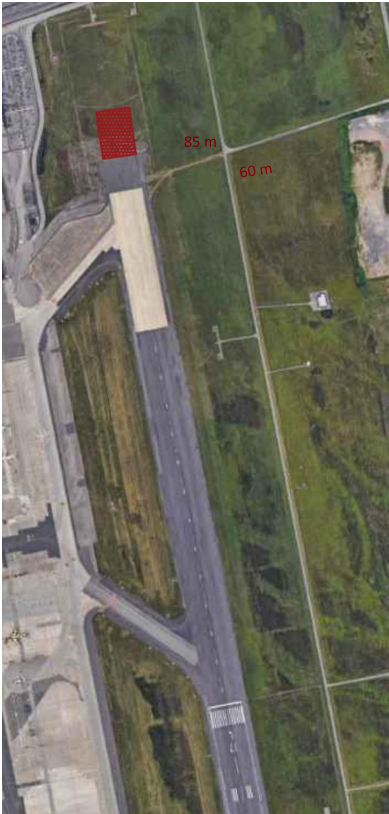
Figura 6 – Realizzazione EMAS (60 X 85 metri) a fine pista 35R
